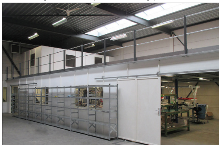
Wand en kantooruimte met melaminepanelen
